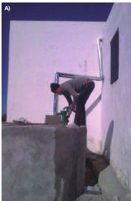
A) Dispositif de captage des eaux pluviales : canalisations, citerne et pompe. B) Captage des eaux pluviales : toiture, gouttière et réservoir.
