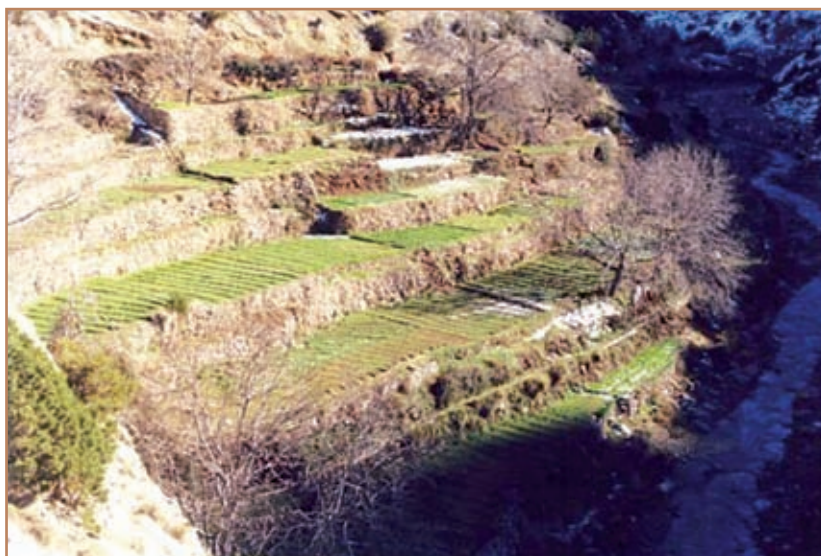
Terrasses construites sur berge et consolidées par des murs en pierres sèches
