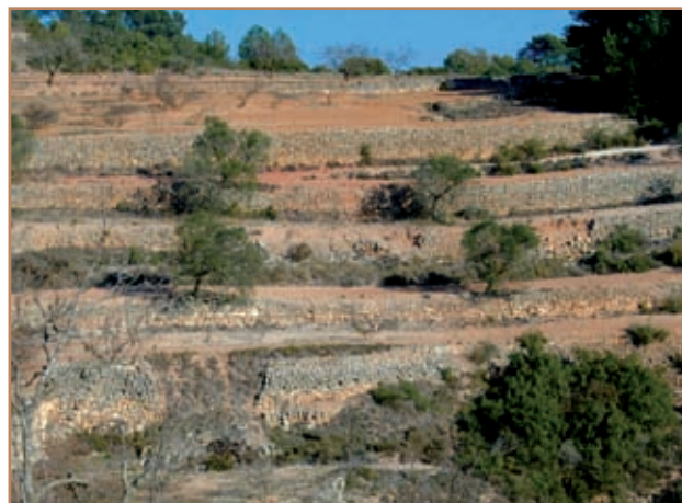
Les terrasses en gradins soutenues par des murs
