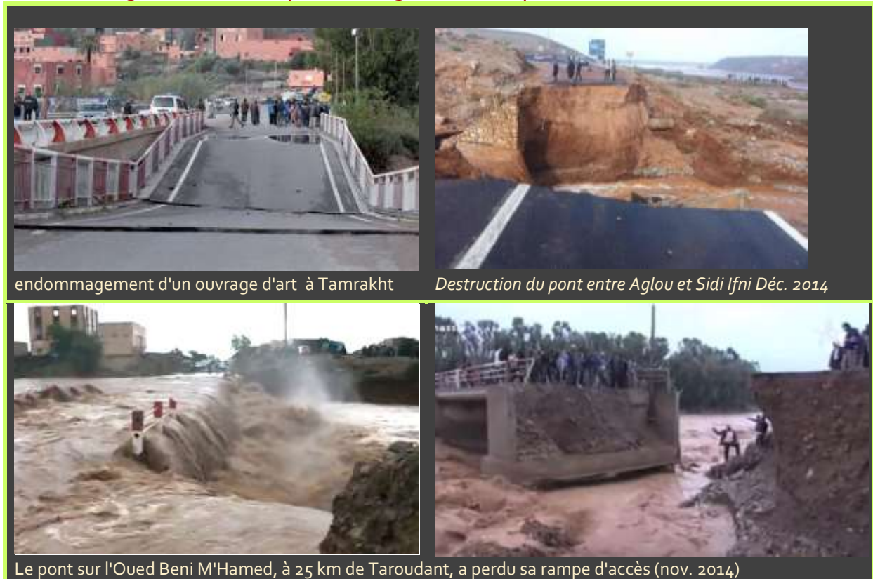
Figure 18 : Exemples de dégâts causés par les inondations en 2014
