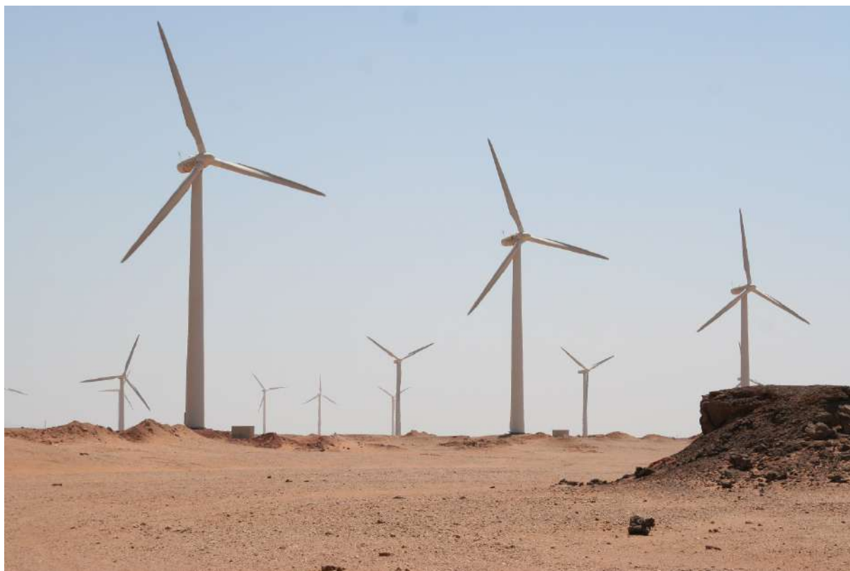
Zafarana, Egypte – ©ENERGIES 2050
