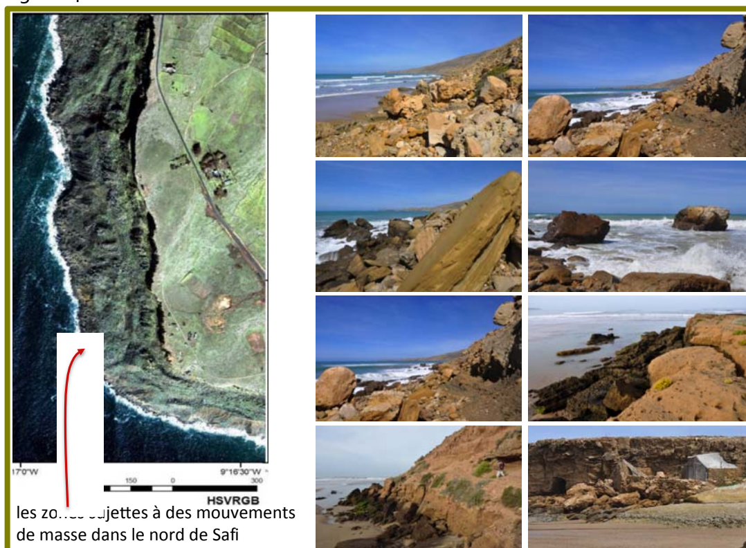
Figure 42: Phénomène d'érosion de la côte rocheuse entre Safi et Essaouira
